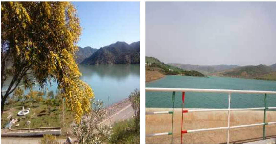
Figure I.8 : Barrage Sidi M'hamed Ben Taiba (Arib) [57].
