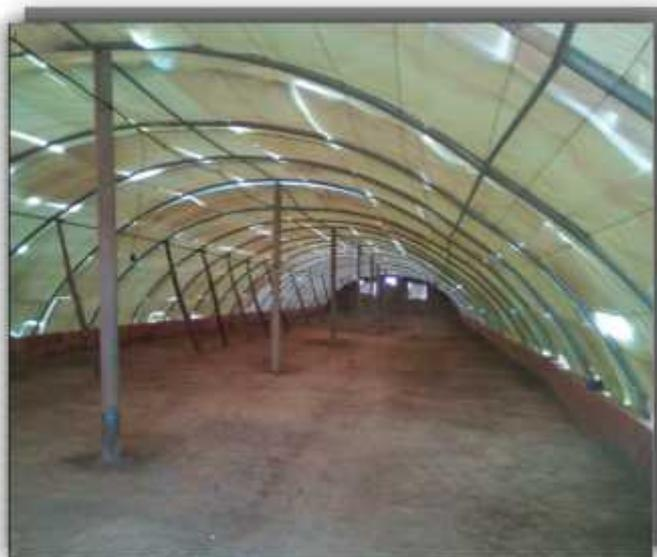
**Photo 8 :** Toiture en polystyrène et nylon
