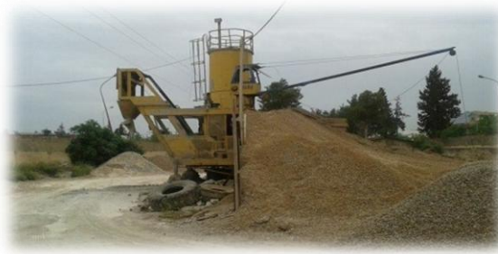
Figure V.4 Centrale à béton
