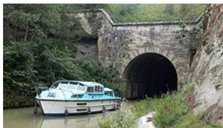
Figure II.1 Le tunnel de Malpas sur le canal du
