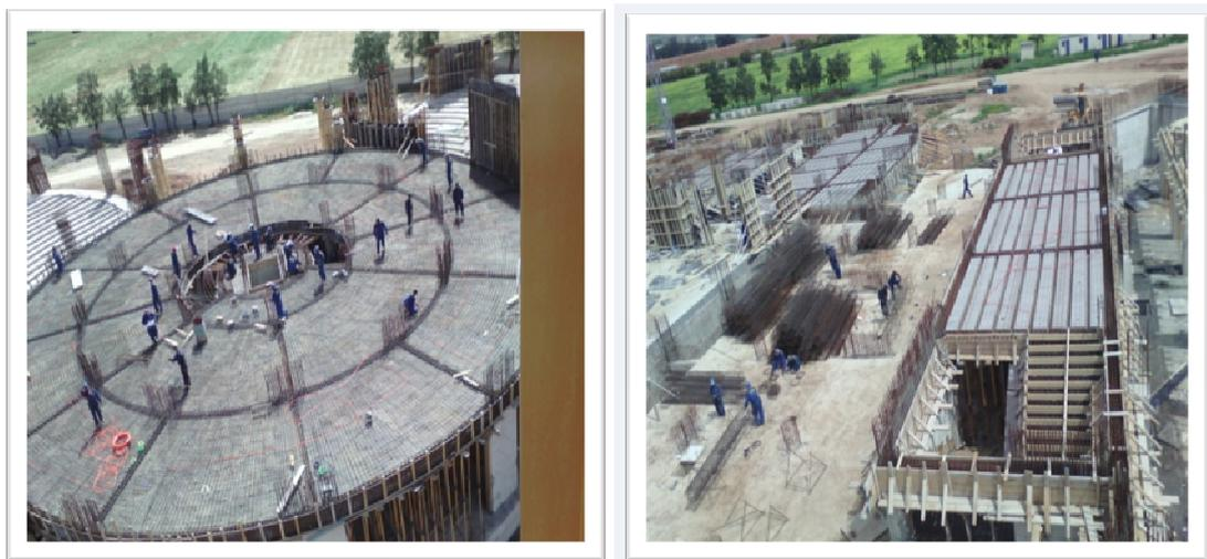
**Figure II.15 : Ferrailage de plancher**
