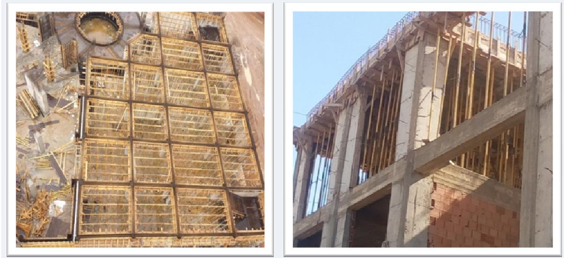
**Figure II.14 : Coffrage de plancher**
