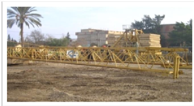
**Figure IV.7** Montage de la grue (l'engin de levage)
