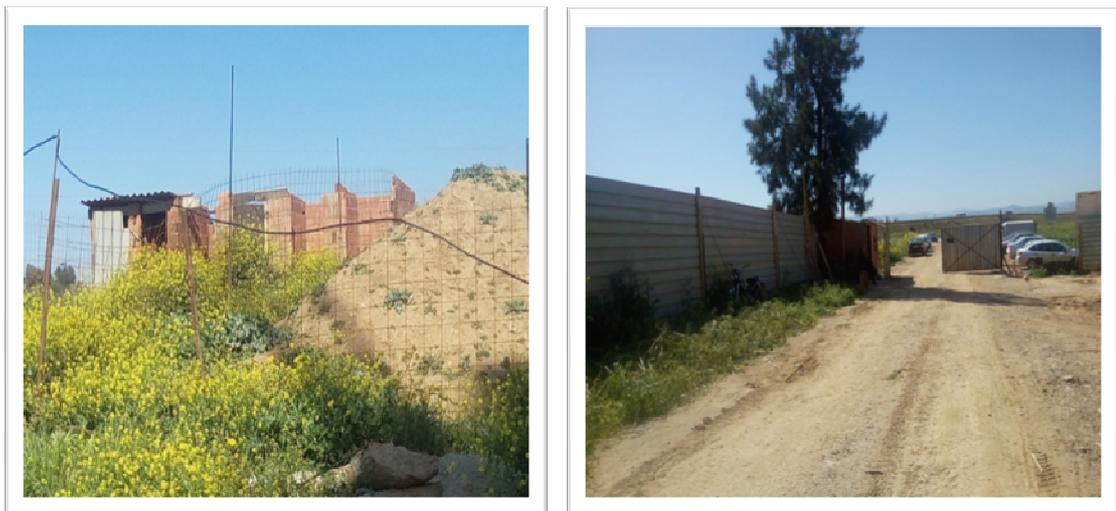
Figure IV.2: Clôture de chantier
