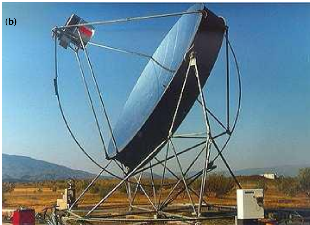
Fig.1.8 : (a) ; Schéma descriptif d'un dish solaire (parabole/Stirling). (b) ; Système DISTAL II de 10 KWe installé à Almería (Espagne)
