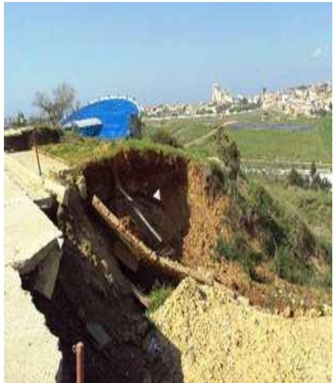
**Figure 12 : Affaissement important de la chaussée.**
