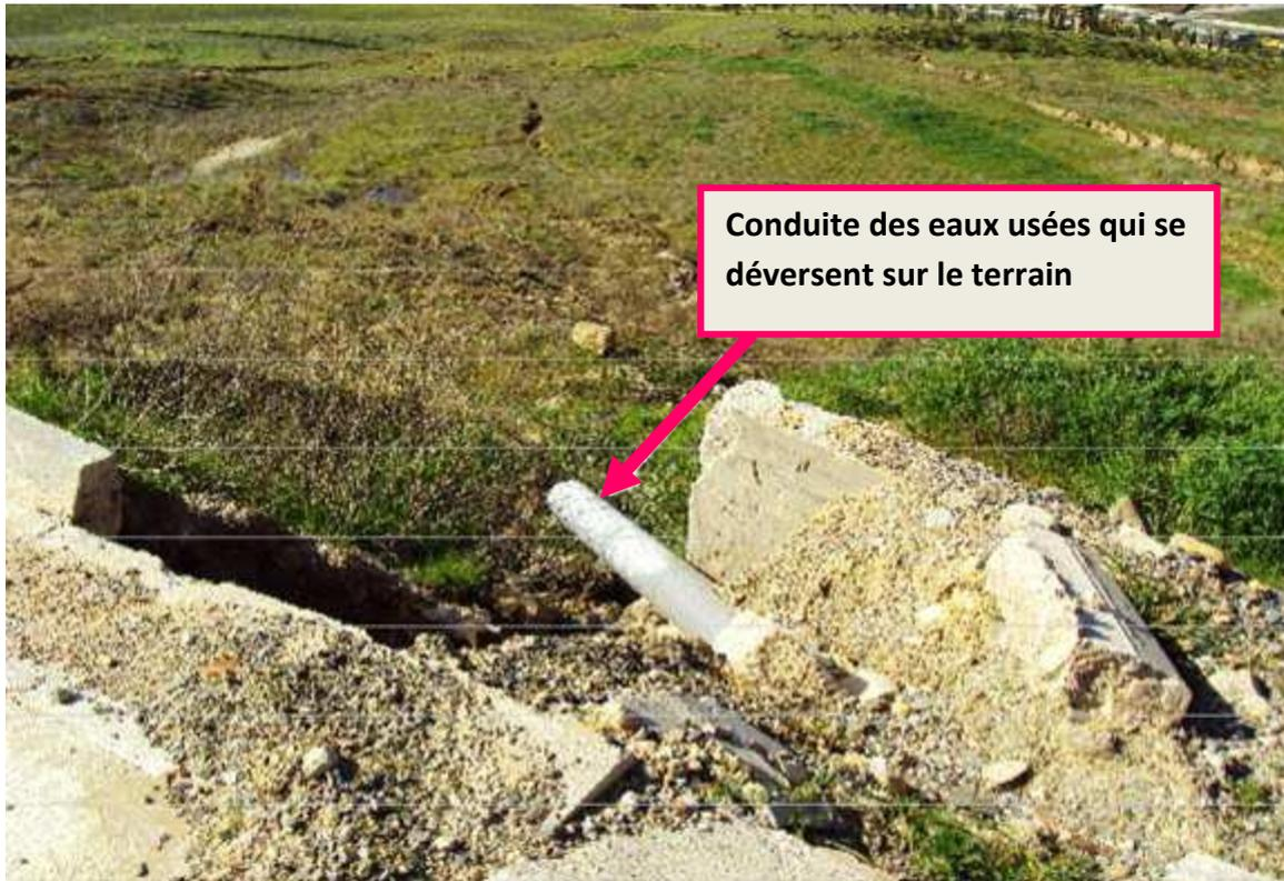
*Figure 17 : rupture de canalisation et déversement des eaux pluviales et d'assainissements dans le talus.*
