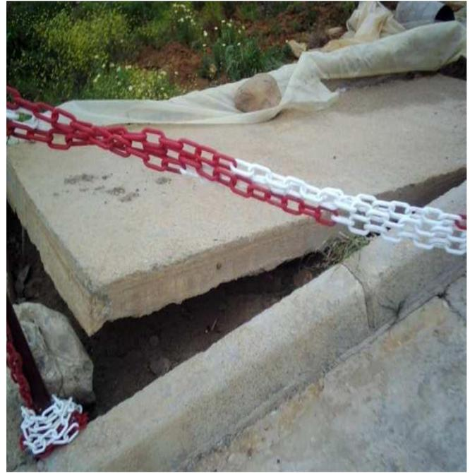
**Figure 11 : Fissures de tractions sur l'accotement de la route.**
