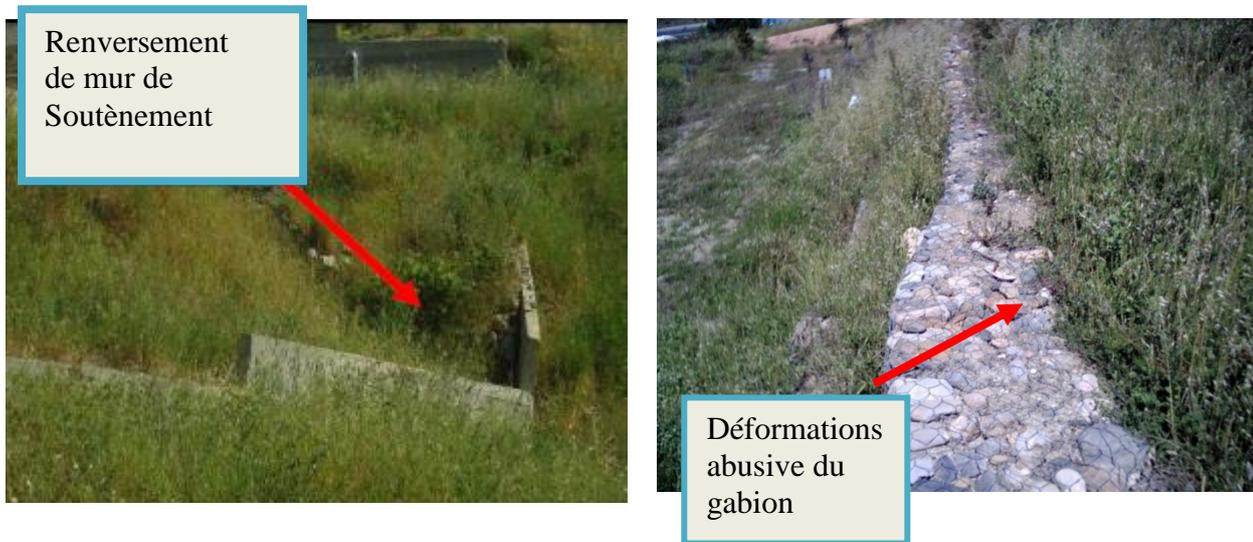
**Figure 15: Rupture des ouvrages de soutènement**
