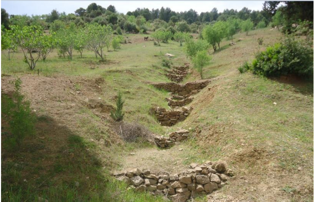
Photo n° 3: Aménagement de l'oued par le système gabionnages dans la zone d'étude
