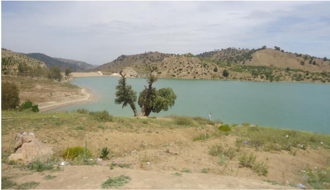
Photo n° 1: Vue de paysage du barrage Koudiet-Rosfa
