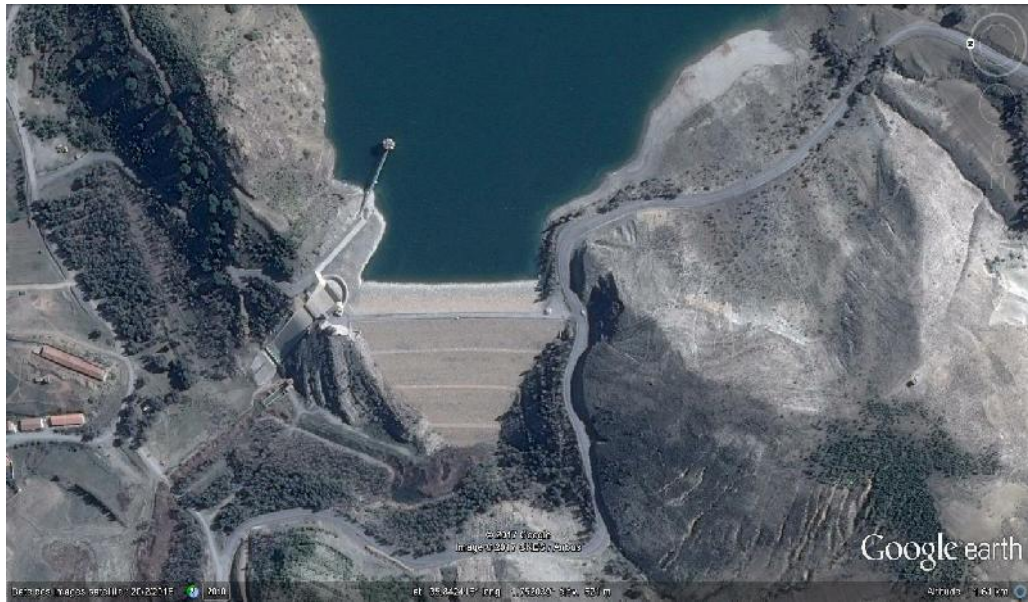
La digue du Barrage Koudiet Rosfa
