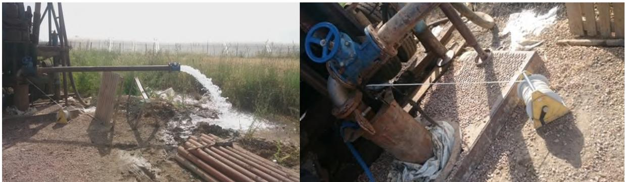
Photo N°14 : Photo montrant le déroulement des essais des pompages au niveau du forage suivi
