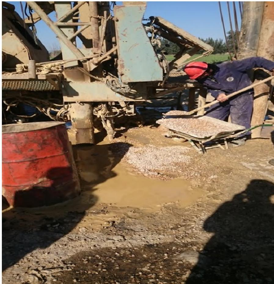
PhotoN°11 : photo montrant la mise en place du massif filtrant.
