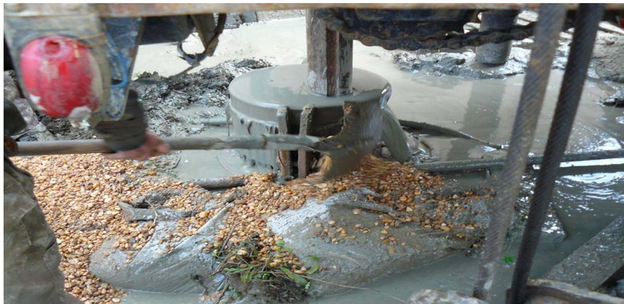
photo 5. la mise en place du massif filtrant.
