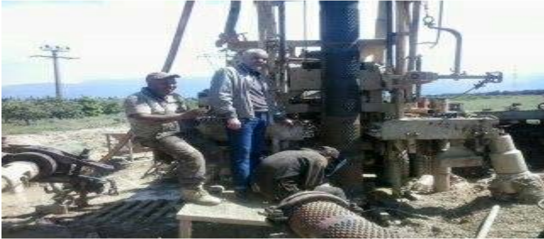
Photo. 4 montre la mise en place du tubage
