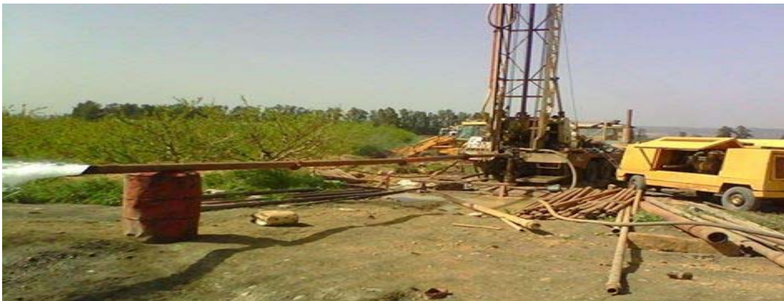
Photo. 6 le développement à l'air lift (pneumatique), compresseur 16bar
