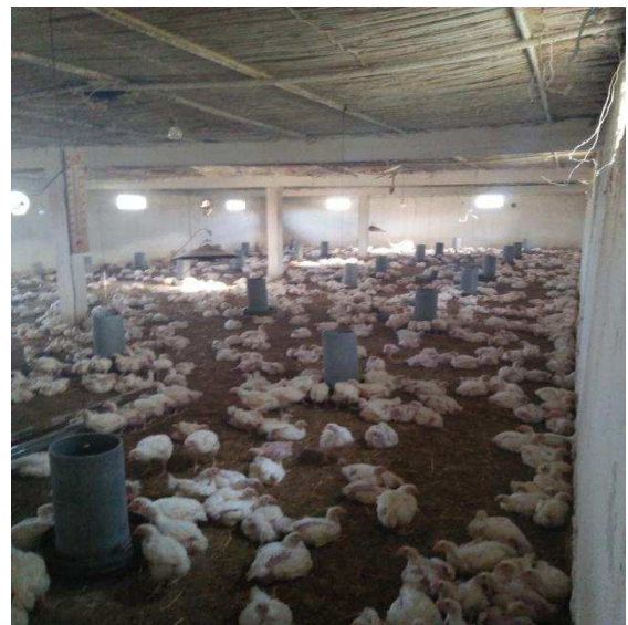
Photo 07 : Toiture en Roseau
