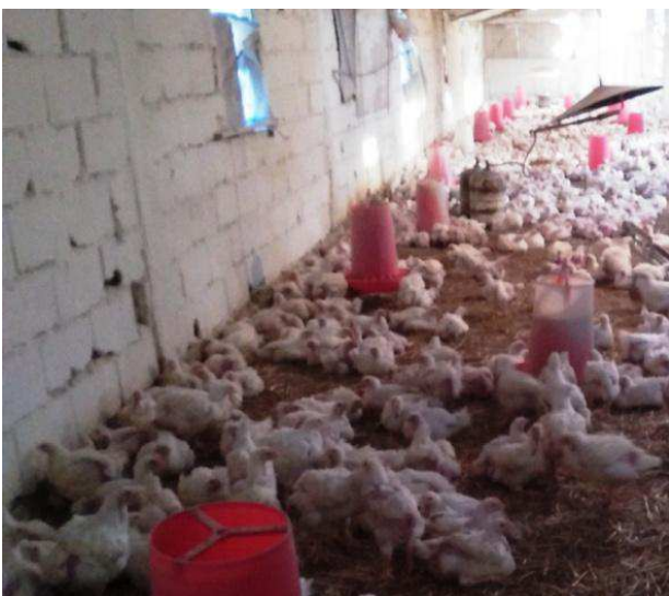
Photo04 : Mur en Parpaing
