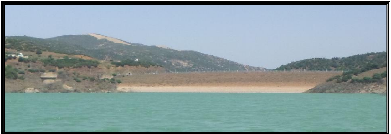
Figure n°12 :photo de la digue (2017).
