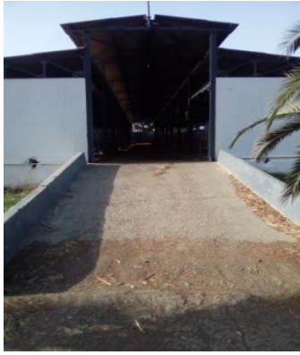
Photo 1 : Bâtiment (bergerie) externe
