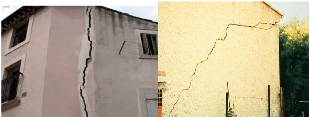
**Fig 1.9 : Fissuration de structure due au sol gonflant**
