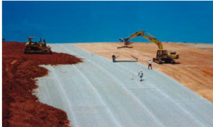
Fig 2.3 : Renforcement de sol à l'aide géotextile
