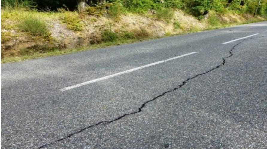
**Fig 1.7 :** Fissuration d'une chaussée de sol instable
